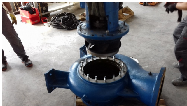
Demontaż wszystkich podzespołów pompy
