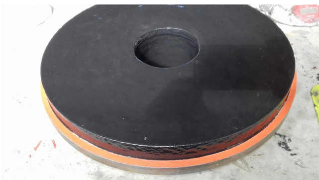
Aplikacja kompozytu ARC 855 oraz uszczelnienia silikonowego Peal & Seal
