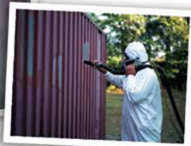
Niskopyłowa obróbka strumieniowo – ścierna
