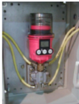
Lubricup EM w smarowaniu wielopunktowym
