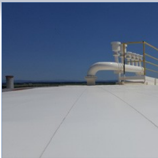
Dach zbiornika po nałożeniu obu materiałów
