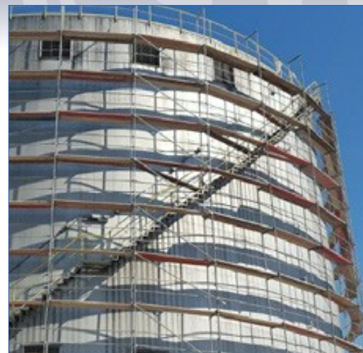
Nakładanie powłoki metodą bezpowietrzną
