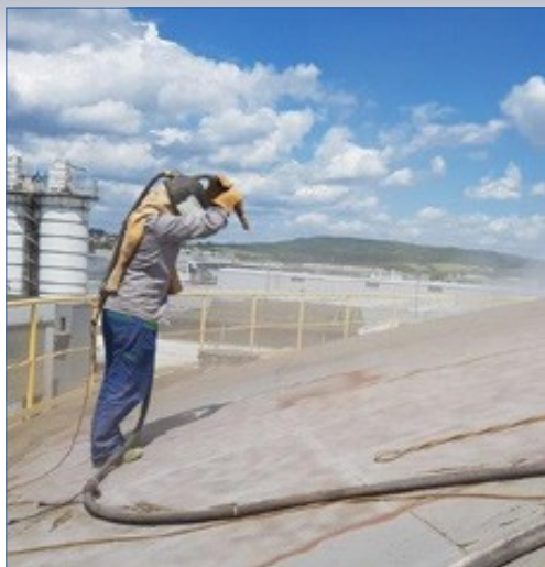
Przygotowanie powierzchni za pomocą obróbki strumieniowo ściernej (do stopnia czystości min. Sa 2.5)
