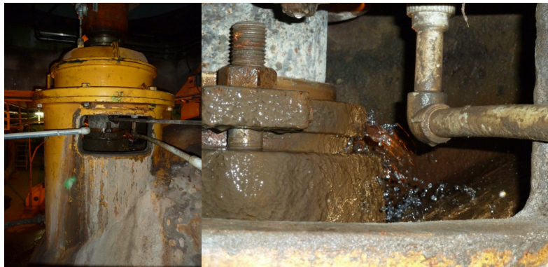
Typowy obraz przy stosowaniu szczeliwa w pompach
